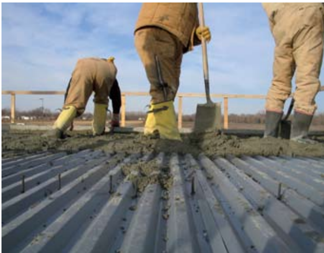
Apply sealer and pour concrete floor slab
